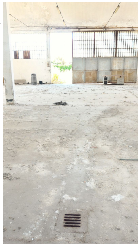
Illustrazione 22 Zona in cui è stata realizzato il Pz3, ed in cui si trovava una rete di raccolta acque interna, allineata con Pz2 e terminante in fognatura. La posizione dei pozzetti è stata scelta anche in base a questa presenza.
